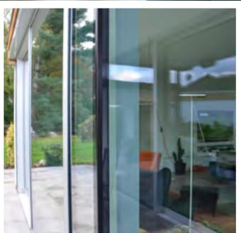
Bauweisen mit 90° Ecken zum Öffnen oder fester Ganzglasecke sorgen für einen fließenden Übergang von Innen- und Außenbereich.
